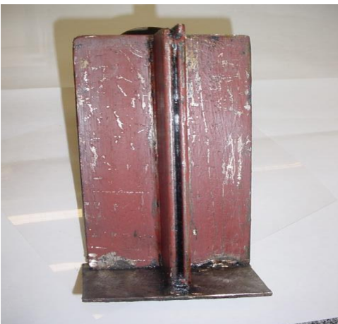
Aspecto da estrutura após 3000 horas de exposição à nevoa salina e remoção do revestimento
